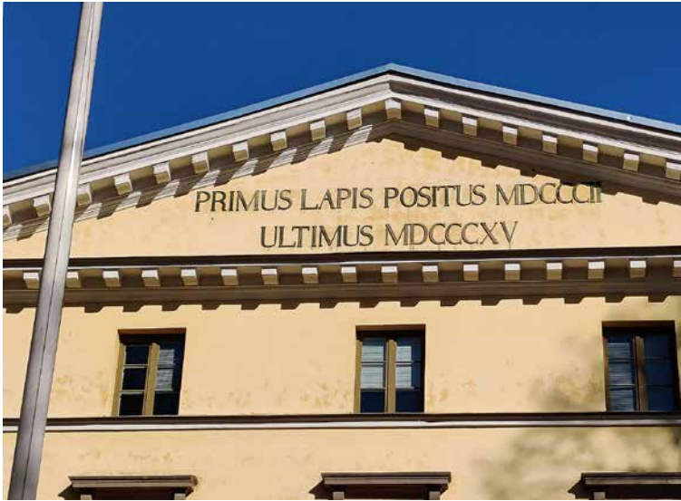
Kuva 2. Turun hovioikeuden rakennus.
