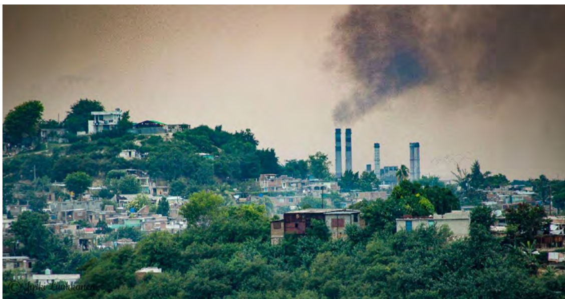
A power plant, Santiago de Cuba (Termoeléctrica)
