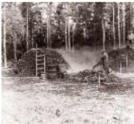
Ennen hiiliuuneja hiilet poltettiin mullalla peitetyissä maamiiluissa. Kuvassa Frans Anttilan ja Juuso Kareston hiilimiilut Honkilahden Auvaisissa 1950-luvulla. Euran kotiseutuarkiston kokoelmat.
